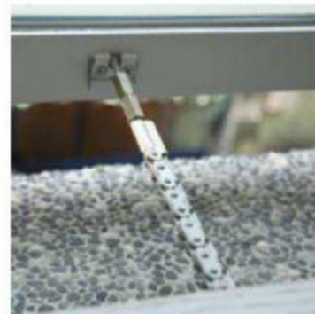
不鏽鋼鍊條式電動推窗， 可配合中控驅動
