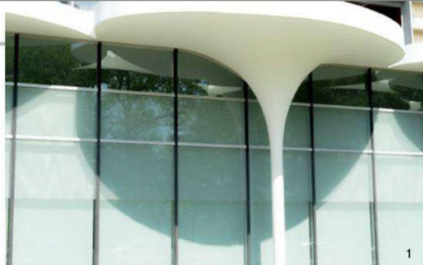
完成年份：2013 地址：台北市羅斯福路四段一號 建築師：伊東豐雄
